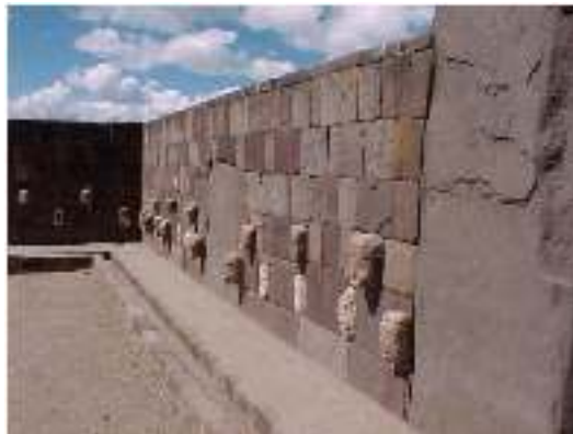
Vista actual de una de las paredes reconstruidas del Templo Semisubterráneo
